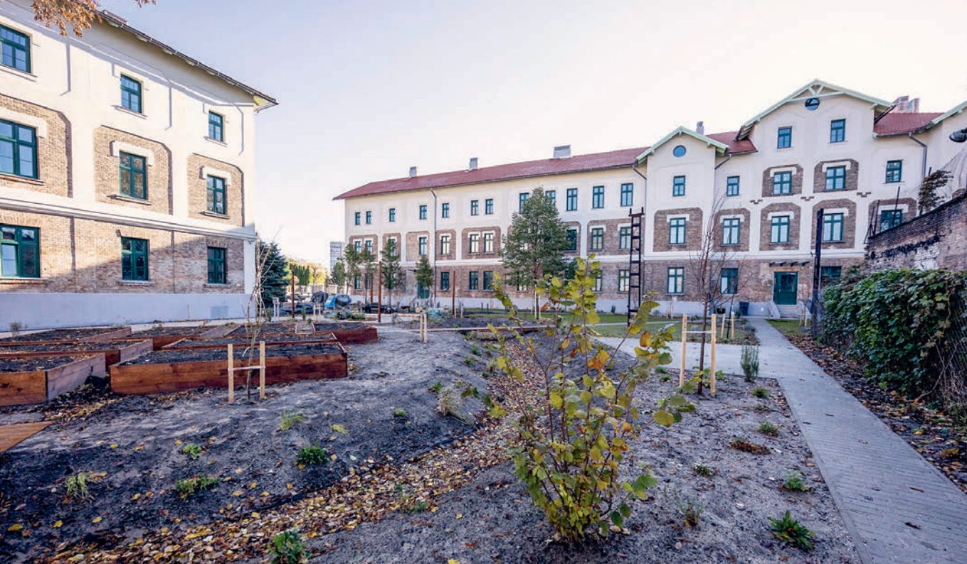
A felújított egykori Kistext lakóházak és közösségi kert a Fáy utcában
