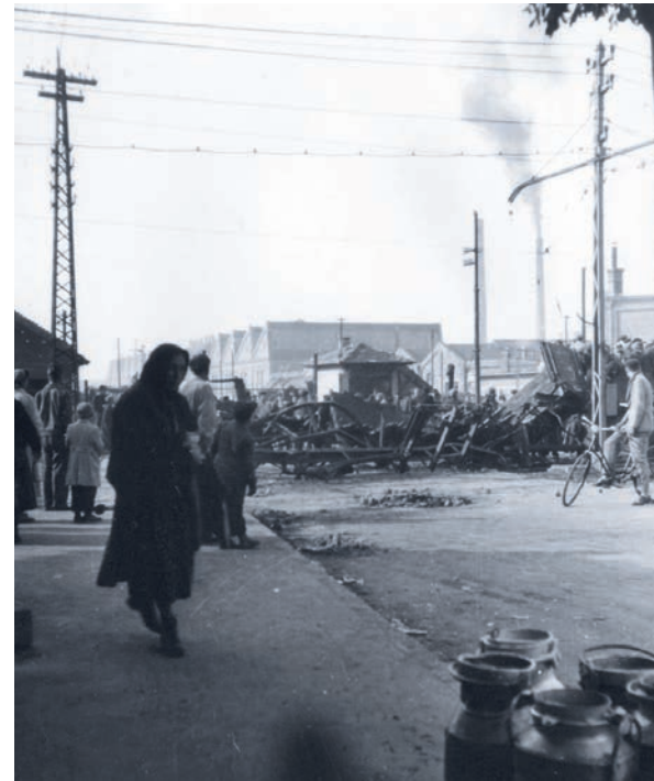
Barikád 1956-ban az Üllői úton Barricade on Üllői Road in 1956
