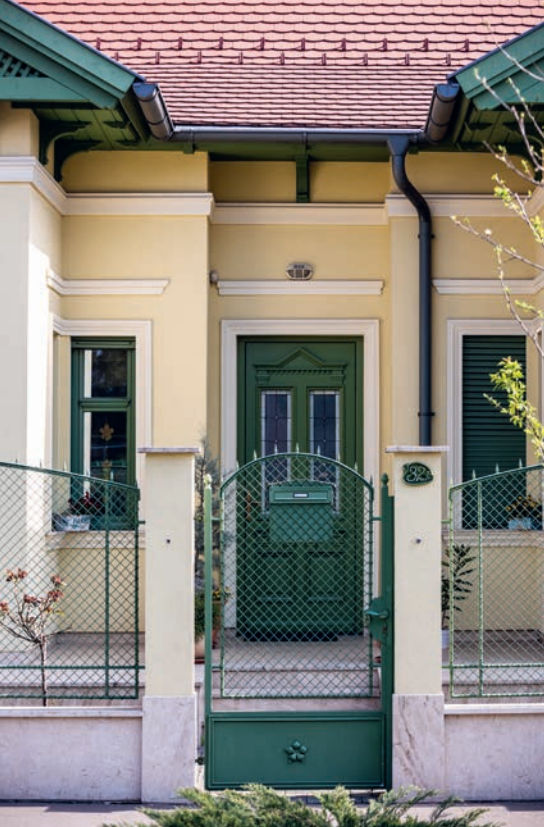
Kertvárosi lakóház az eredeti értékeit megőrző felújítás után
